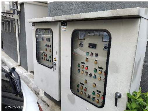
ตู้ควบคุมบ่อสูบน้ำเสีย
